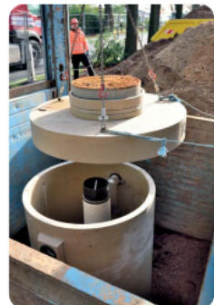
Einbau eines Leichtflüssigkeitsabscheiders
